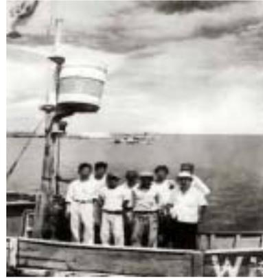
図4 . テント船 . 柱上の桶は鯨の見張り用のもので昭和二十五年頃から使用されるようになった。トップと言っている。
